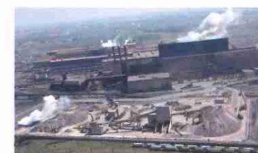
À Dunkerque, installation d'élaboration des granulats de laitier de convertisseur : criblage et déferailage.
